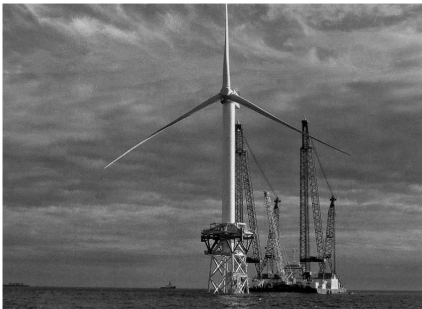
Kuva 1. Ensimmäistä 5 MW:n tuulivoimalaa asennetaan avomerelle.
